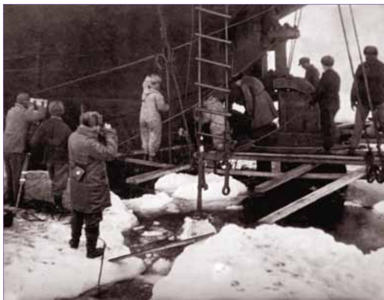
Замена сломанных лопастей винта ледокольного парохода «Сибиряков». Чукотское море у о. Колучина. Сентябрь 1932 г.
