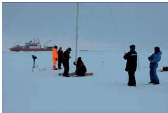
Монтаж оборудования метеоплощадки
