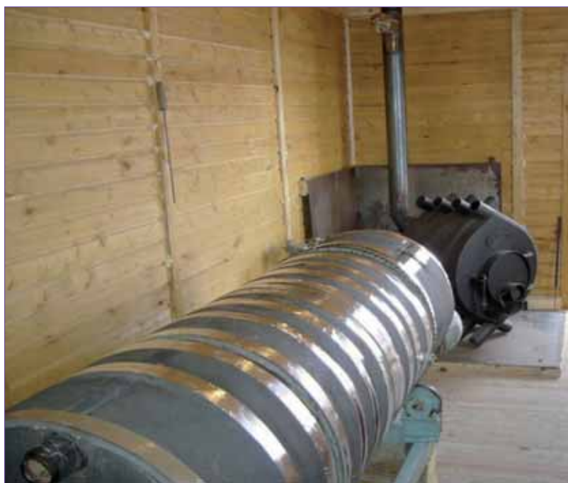
Размещение ферментатора в модульном пункте переработки отходов жизнедеятельности полярной станции на полевой базе Дружная-4. Фото предоставлено авторами статьи
