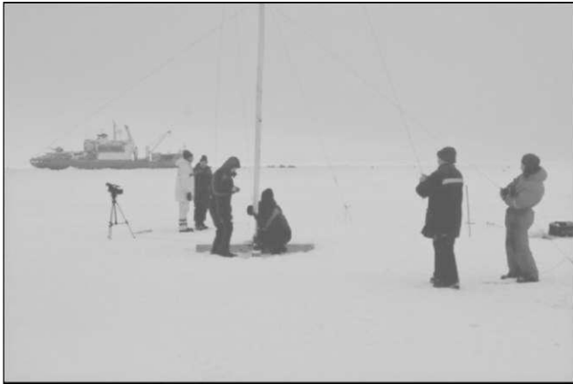
Монтаж оборудования метеоплощадки
